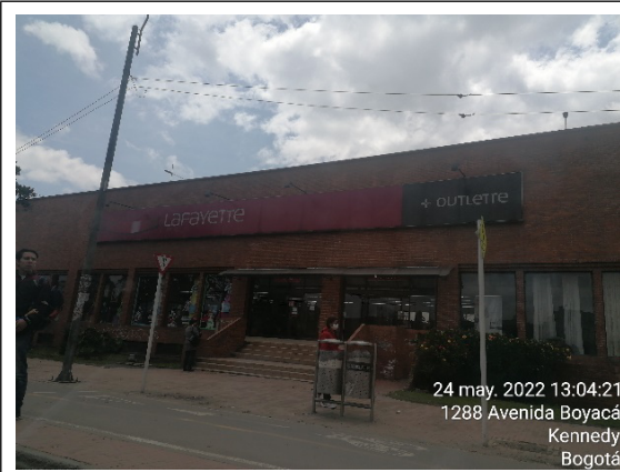
FOTOGRAFÍA No. 1. Fachada
